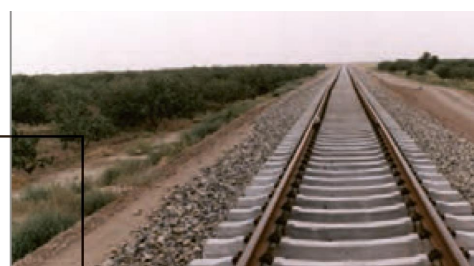
شکل ۱۳-۴. بالاست در زیرسازی جاده ریلی
