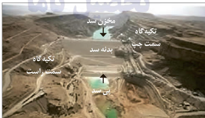
شکل ۴-۵. نمایی از بخش‌های مختلف یک سد
